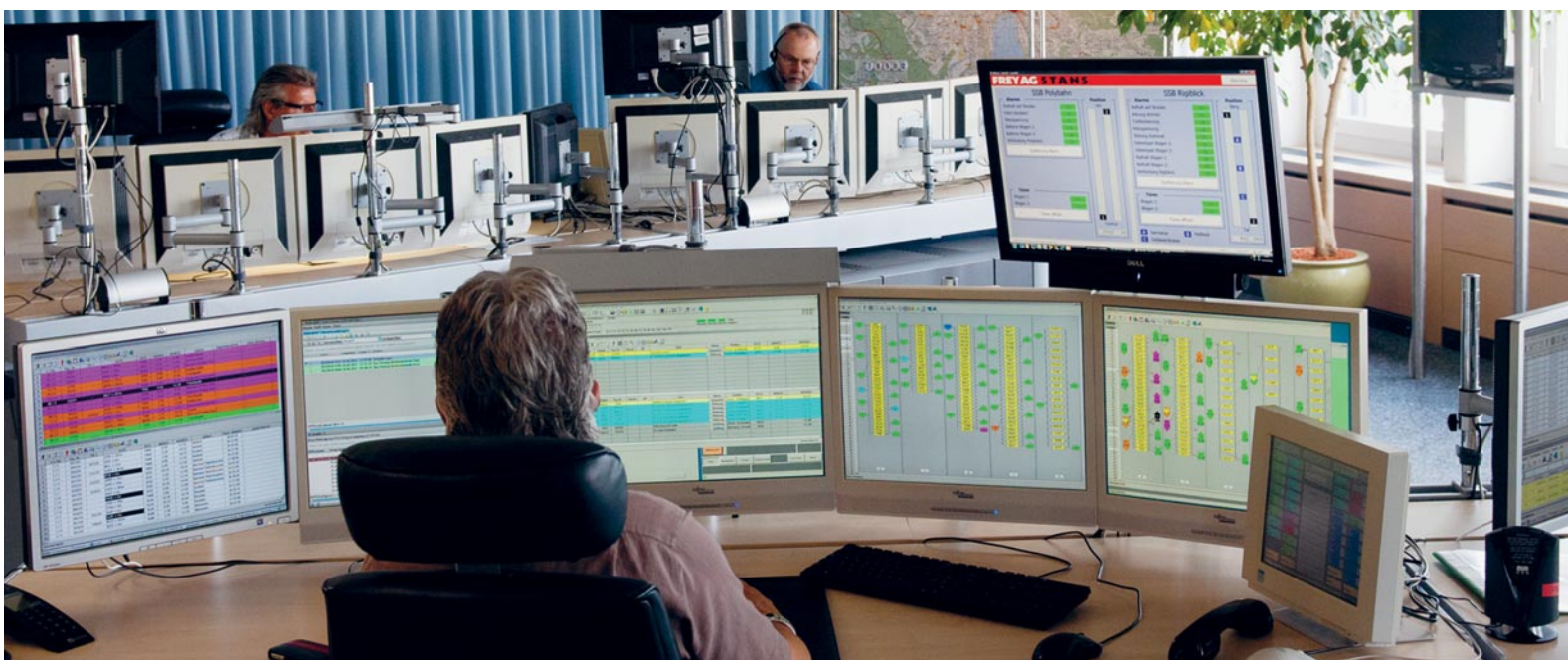
Die gesamthaft fünf Arbeitsplätze haben eine moderne Erscheinung. Das Leitsystem nimmt fünf Bildschirme in Anspruch, der sechste Bildschirm umfasst VBZ-interne Anwendungen. Die Zettel auf dem Tisch im Vergleich zu 1990 sind weitestgehend verschwunden, die Protokollierung des Betriebsberichts erfolgt elektronisch.
