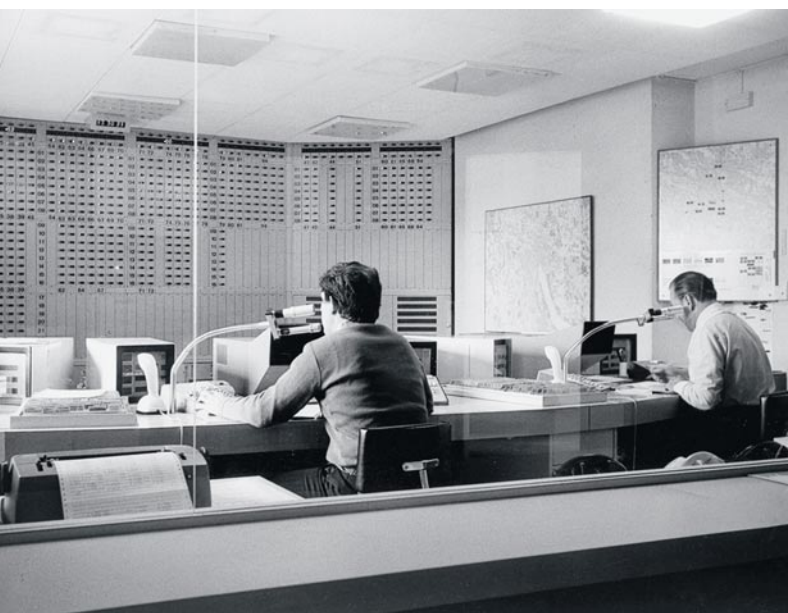
Über eine Tastatur konnten die Disponenten gewünschte Fahrzeuge computerunterstützt per Funk aufrufen. Der «Schwanenhals» umfasste Mikrofon und Lautsprecher für die Kommunikation.
